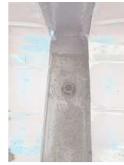
ダクト清掃後
